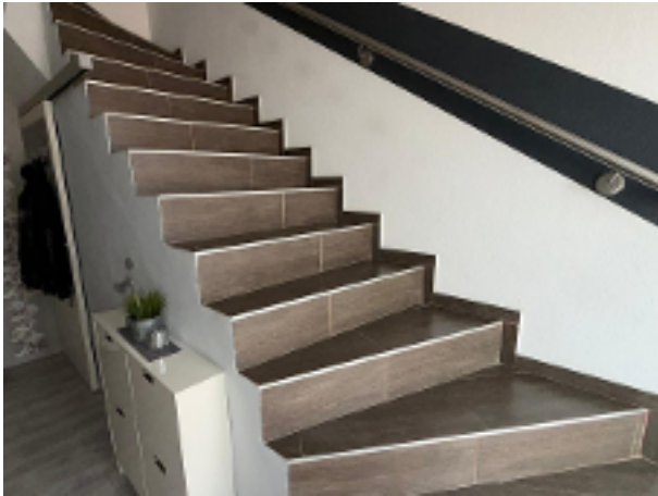
Treppe zum OG
