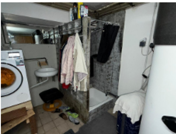
Dusche im Keller
