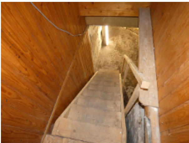
Treppe zum Keller 22
