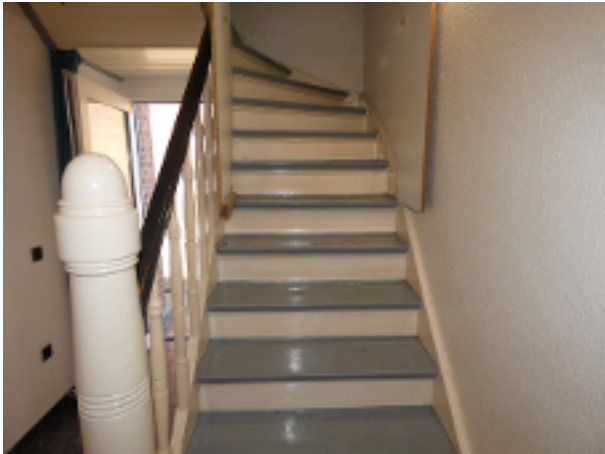
Treppe zum DG 22
