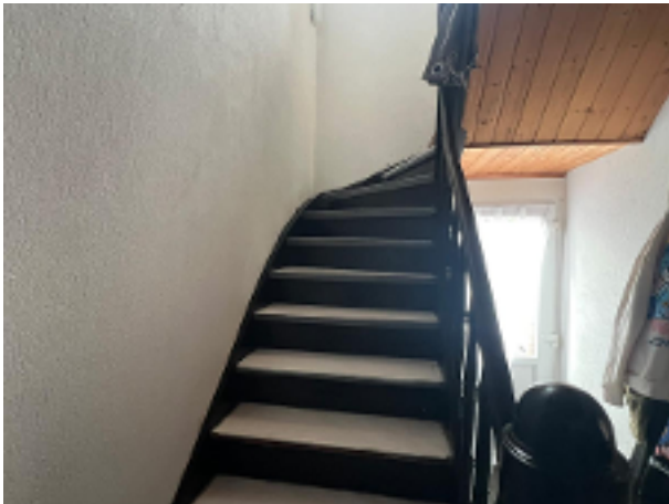
Treppe zum DG 20
