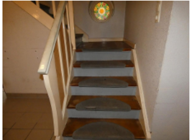
Treppe zum DG
