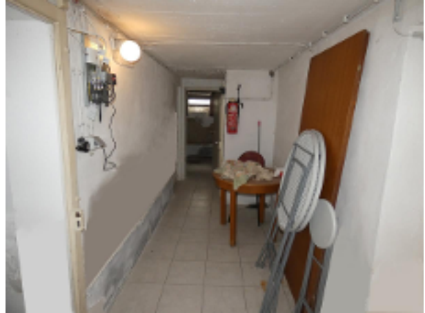
Flur im Keller
