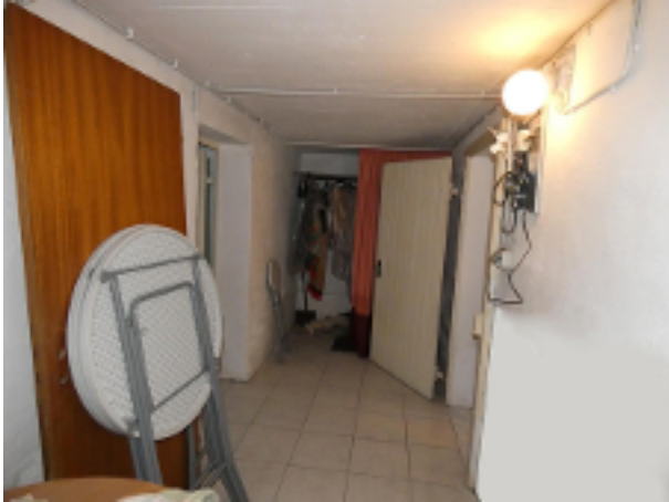
Flur im Keller
