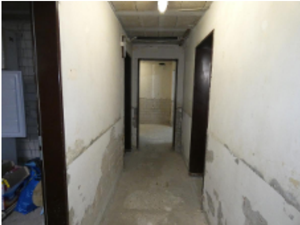
Flur im Keller
