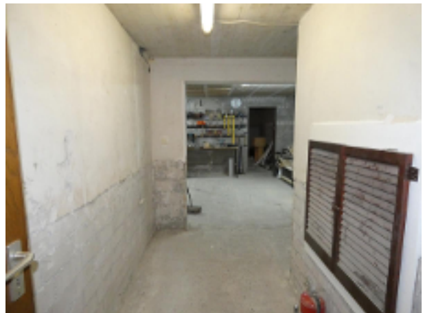
Flur im Keller
