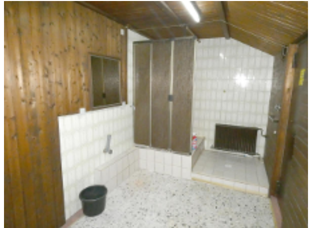
Dusche im Keller
