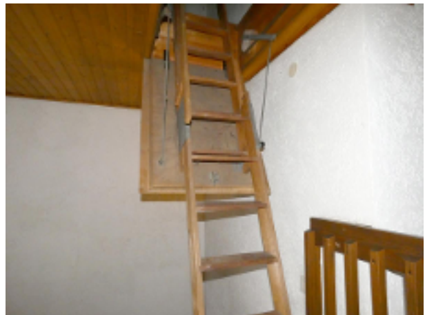
Treppe zum Spitzboden
