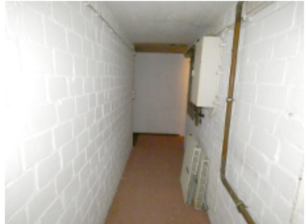
Flur im Keller
