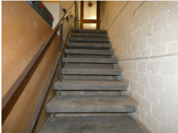
Treppe zum Aufenthaltsraum
