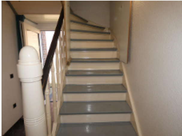
Treppe zum DG 22
