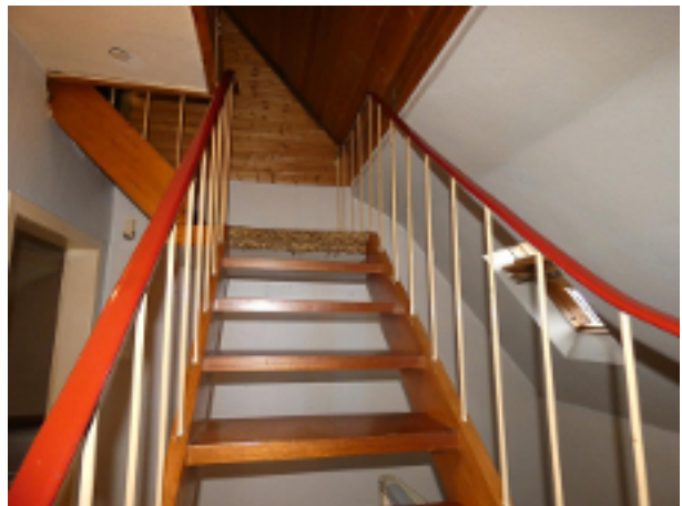
Treppe zum Spitzboden
