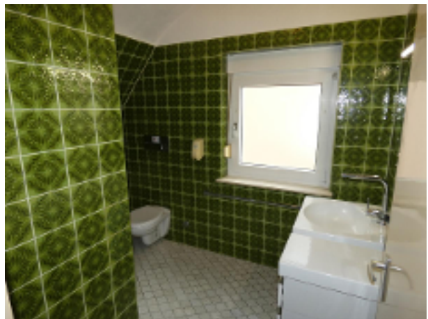
Bad im DG
