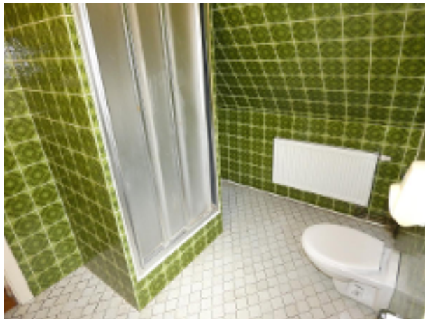
Bad im DG
