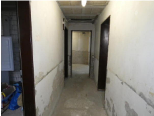
Flur im Keller
