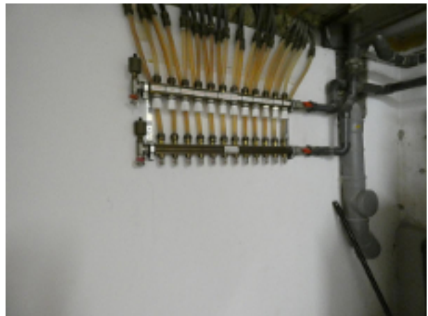
Fußbodenheizung
